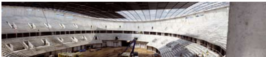
Znamiennym kształtem charakteryzuje się dach o rozpiętości 123,30 m, o układzie linowym, tzw. paraboloidzie hiperbolicznej.
